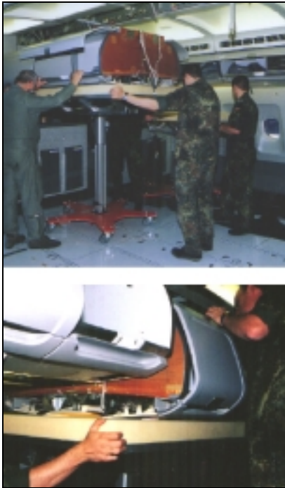
Bild 9.44 Installation Hatracks (WTD 2003)
